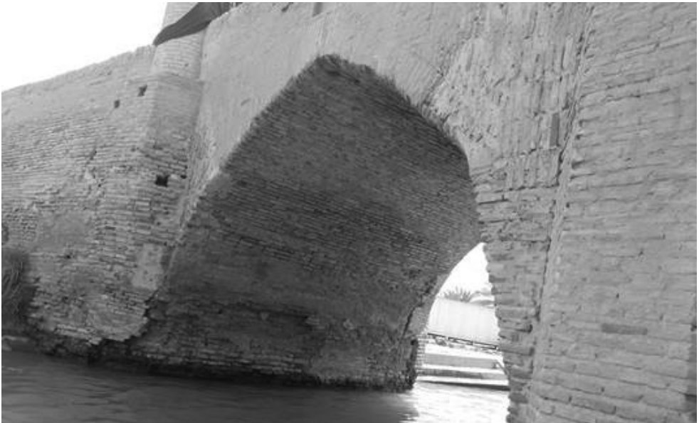
شكل ٧: عقد القنطرة لوح يظهر في اعلاه وفي جوانبه طريقة التلاعب بصف الأجر بشكل عمودي وأفقي / تصوير الباحث
